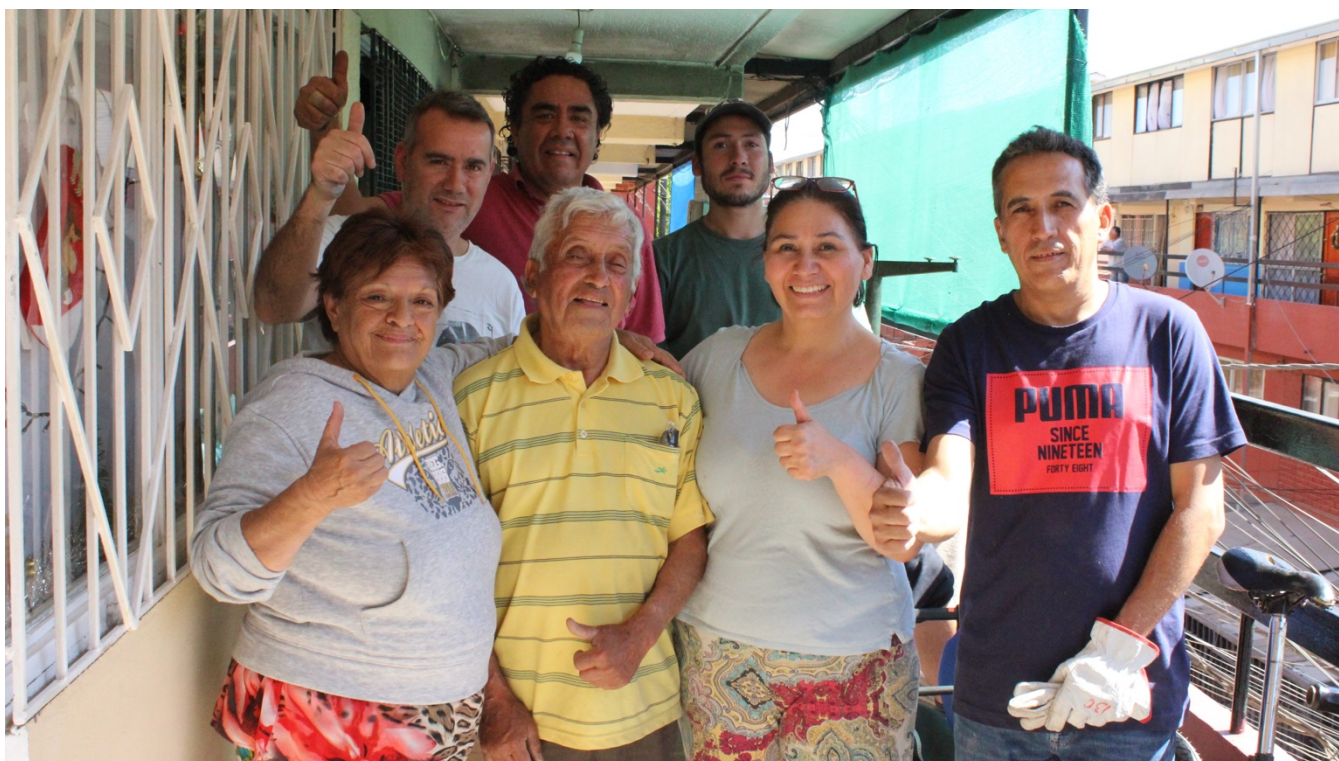
Estudiantes del curso "Electricidad domiciliaria" en instalación eléctrica solidaria a vecina afectada por incendio.
